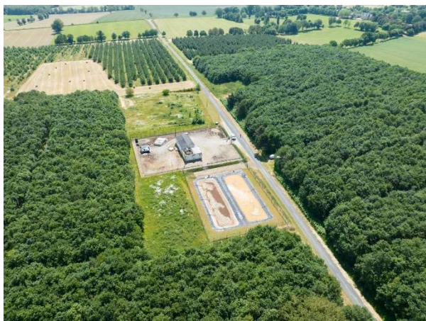
Captage et station de l'Eperonnière
