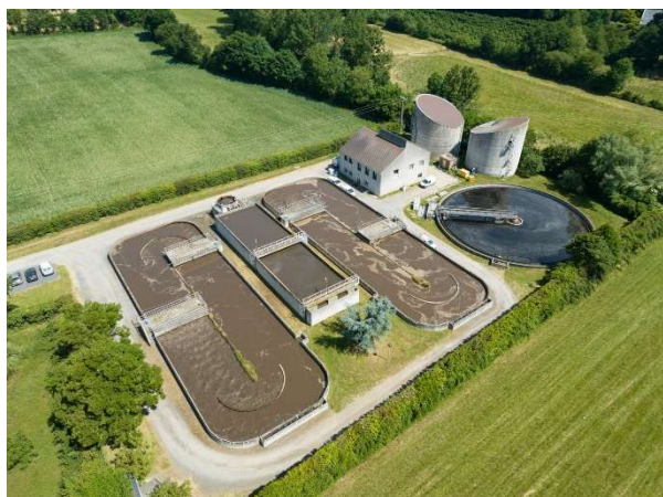
Station d'épuration de Craon
