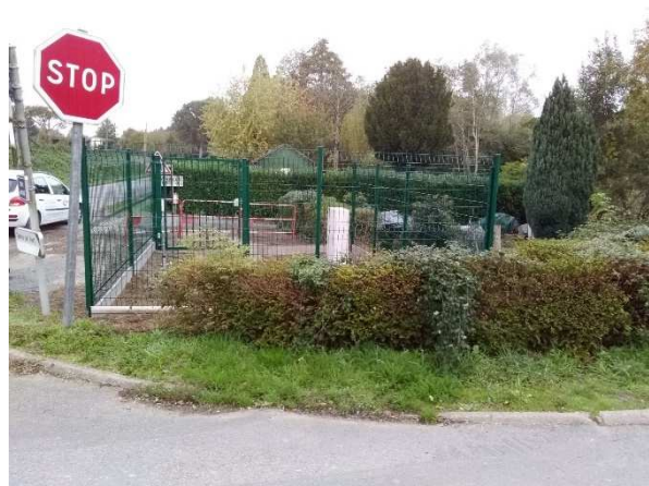
Poste de refoulement d'Athée
