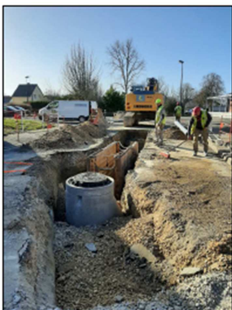
Chantier EU - rue de la Tour du Guet à Craon
