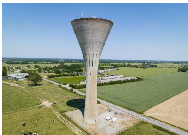
Réservoir sur tour de Fontaine Couverte (3000 m 3 )
