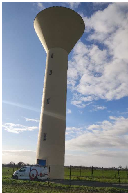
Château d'eau de DENAZE exploité en DSP
