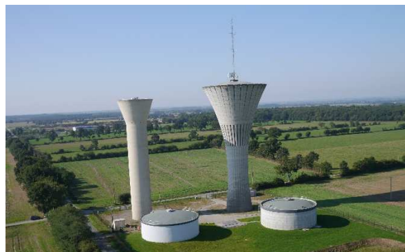
Site de stockage de Forêt Neuve
