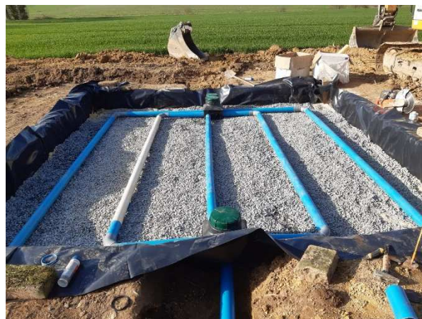
Réalisation d'un filtre à sable drainé
