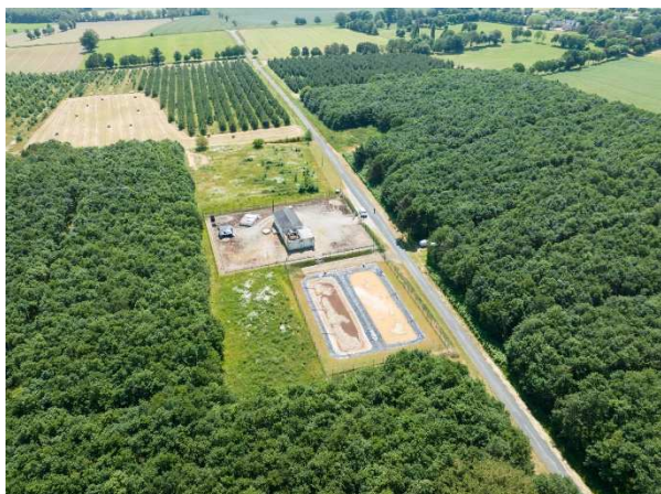
Captage et station de l'Epronnière
