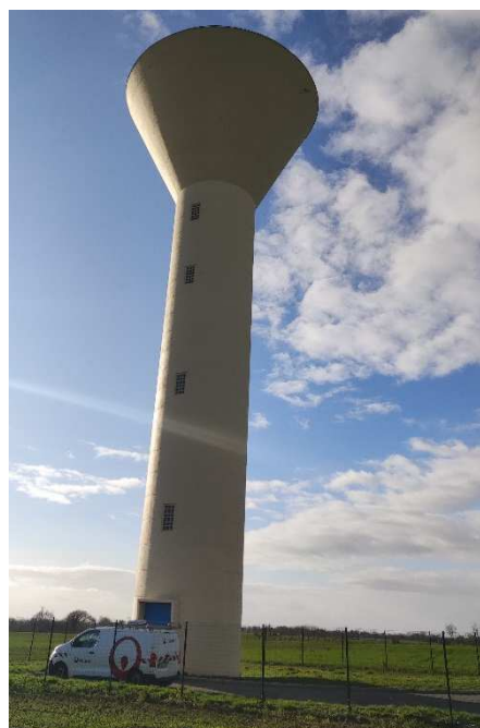
Château d'eau de DENAZE exploité en DSP
