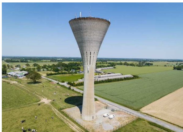
Réservoir sur tour de Fontaine Couverte (3000 m 3 )
