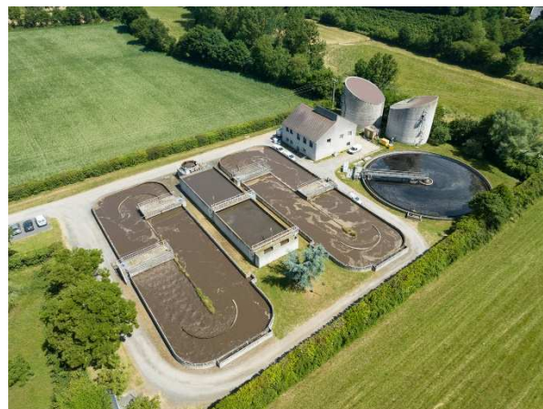
Station d'épuration de Craon
