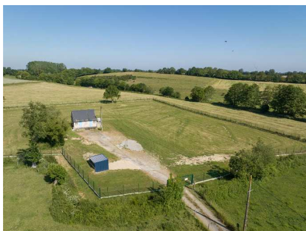
Captage et station des Friches
