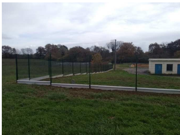
Clôtures rinnovées sur le site de La Marinière
