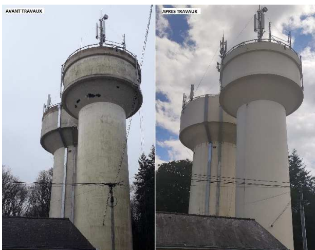
Rénovation du château d'eau de Renazé
