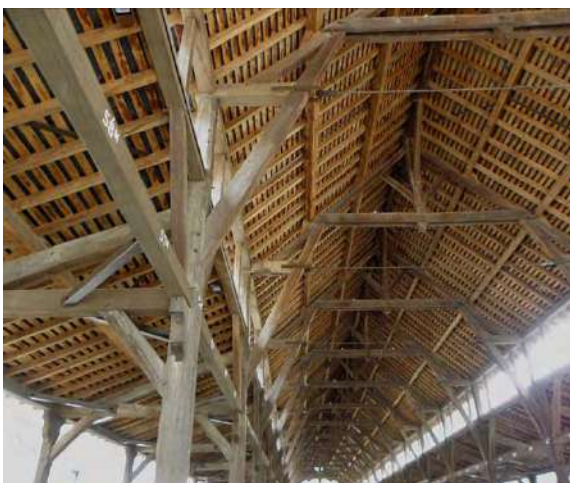
Détails sur la charpente des halles classées
