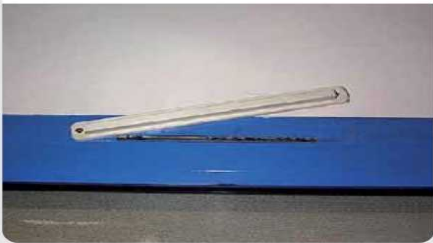
Photo 7 : Entrée d'air avec réservation trop étroite
