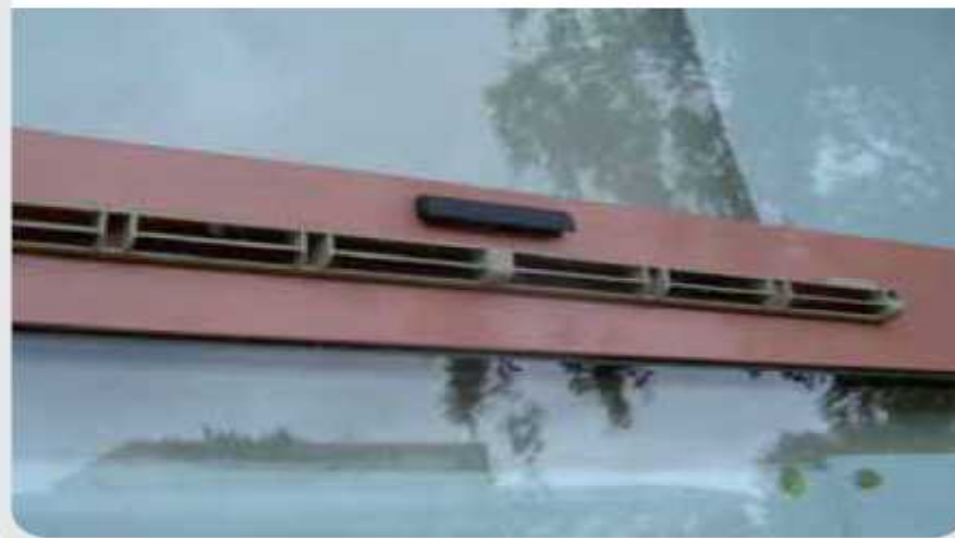
Photo 8 : Entrée d'air dans une fenêtre
